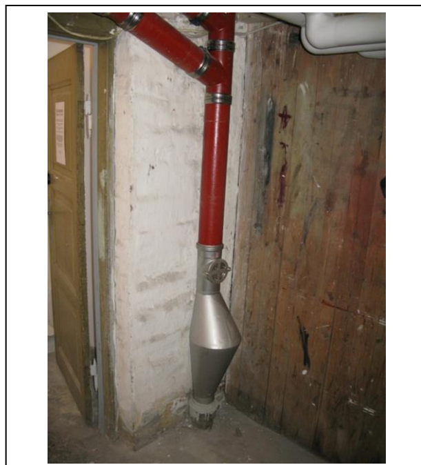
Eksempel på udskiftet faldstamme og rottetop for WC-rum i kælder
