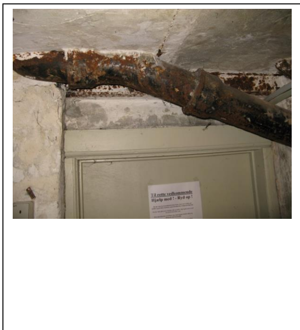
Eksempel på faldstamme i kælder
