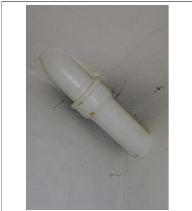
Eksempel på begyndende rustdannelse
