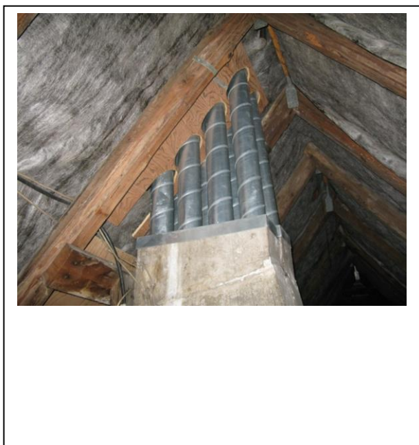
Eksempel på korrekt opføring af kanaler, ved "manifold"-metode
