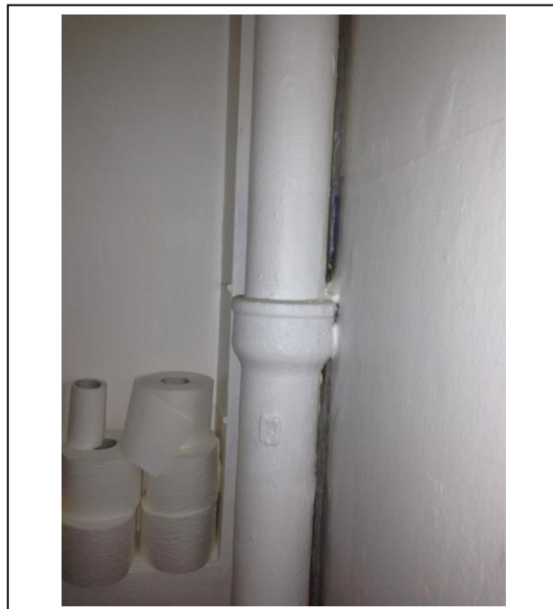
Eksempel på eksisterende faldstamme
