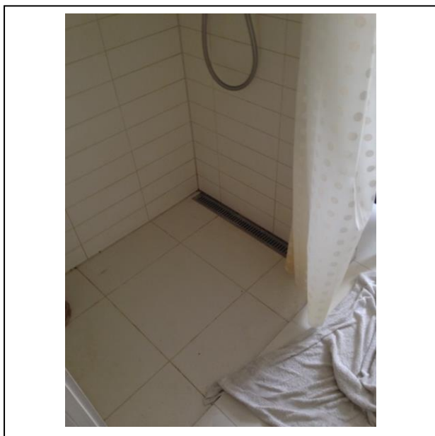
Eksempel på istandsat WC/bad.
