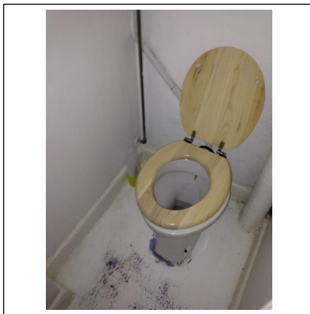
Eksempel på eksisterende toilet-rum. WC er med højtskyl.
